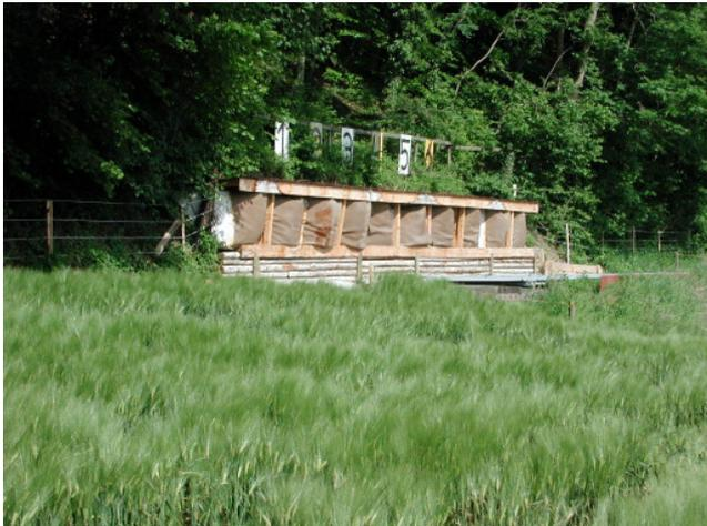
Kleine Schiessanlage mit relativ geringer Schiessstätigkeit. Anstelle von Kugelfangkästen wurden mit Holzschnitzeln gefüllte Grosssäcke eingebaut. Die Säcke sind mit einer Gummihaut abgedeckt. Das System ist weniger dauerhaft als die Kästen, aber wesentlich günstiger (weniger als Fr. 1'000 pro Scheibe bzw. Sack). Es eignet sich deshalb für wenig benützte Anlagen und Anlagen, bei welchen die Zukunft noch unklar ist.
