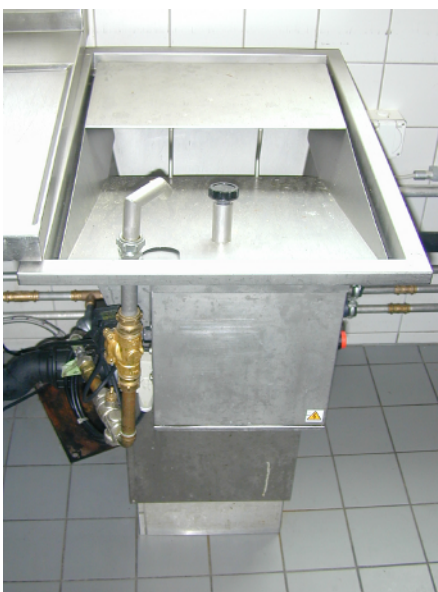
1. Stufe, Speiseabfallzerkleinerer
