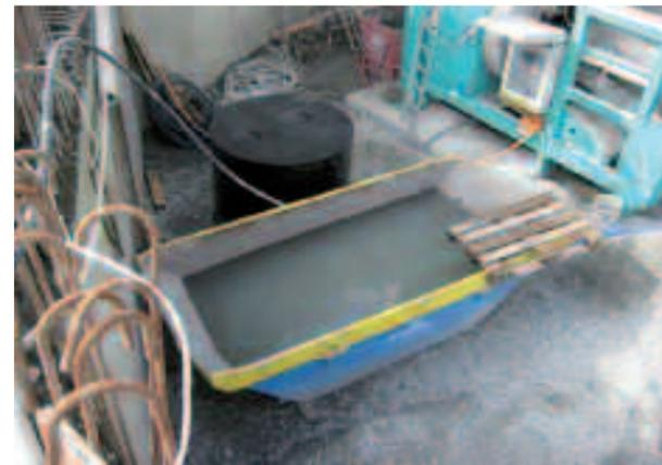
Exemple de traitement des eaux alcalines de chantier par décantation et neutralisation.
